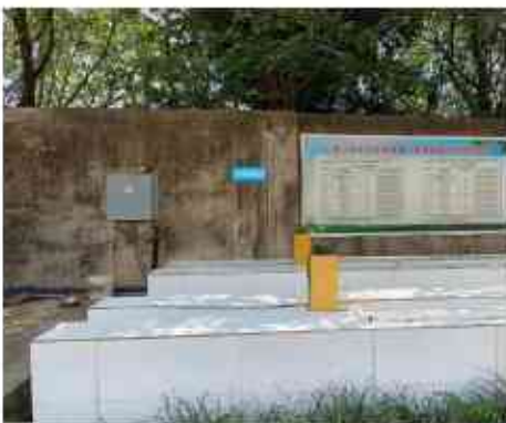
污水排放口（已更新标识标牌）
