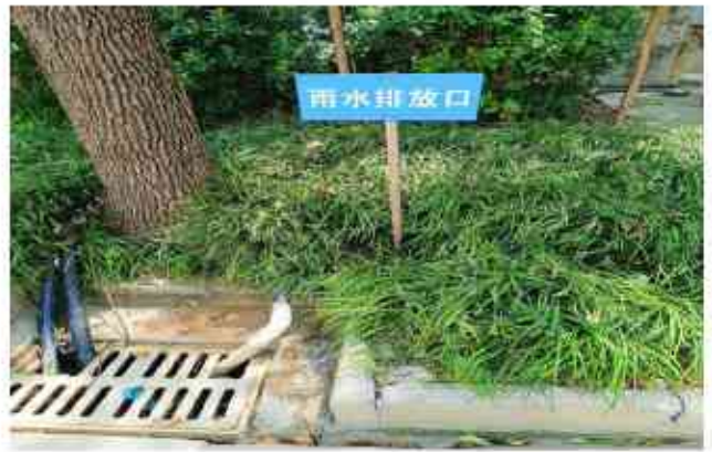
雨水排放口（已更新标识标牌）
