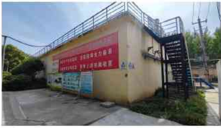
调节池、均衡池
