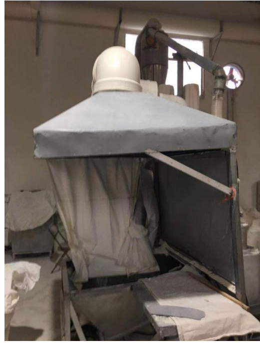
一级球磨粉碎机集气罩及除尘器
