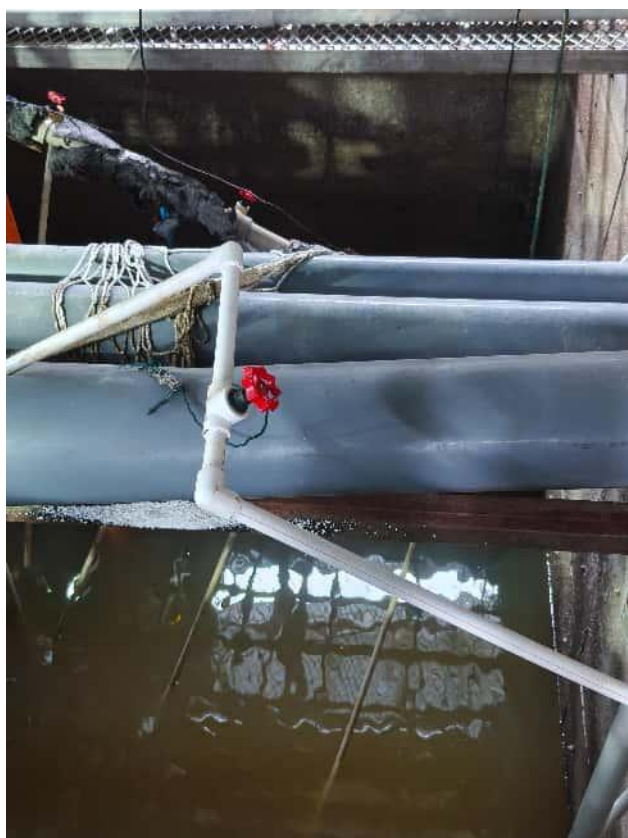
生产废水沉淀池
