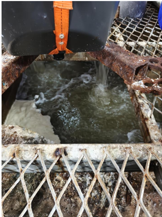
生产废水中和池
