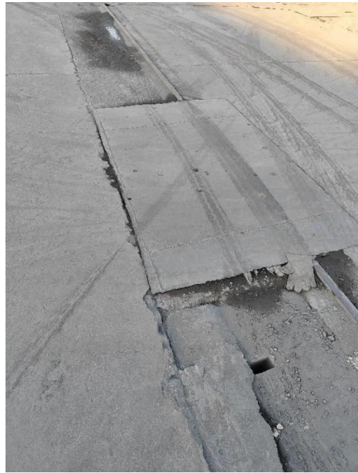
雨水外排阀门井
