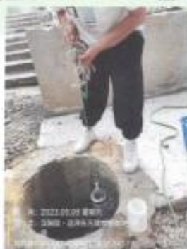
项目区废水总排口(S)
