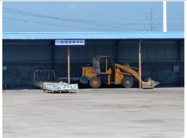
一般固废暂存场所
