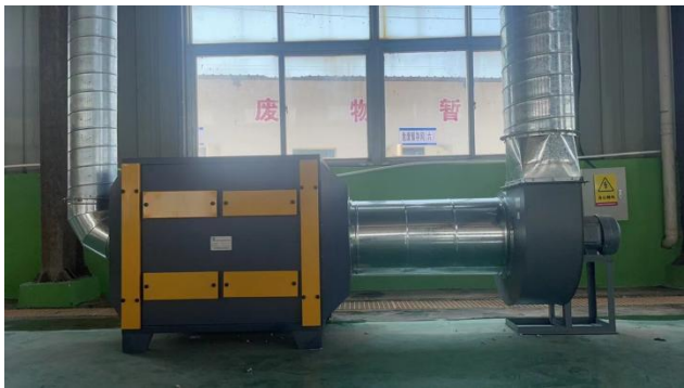
有机废气处理装置
