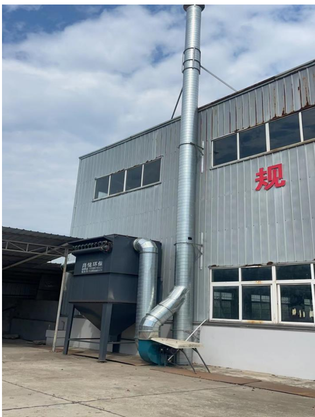
切割粉尘处理装置及排气筒
