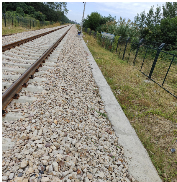
图 5-1 边坡绿化及防护工程照片
