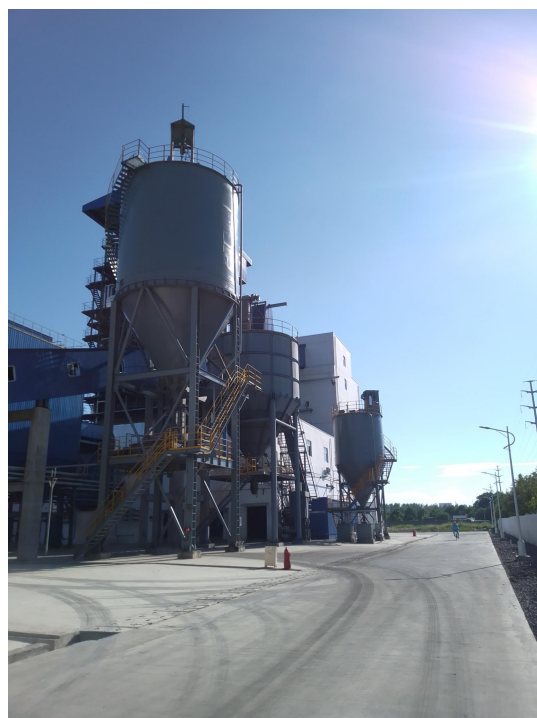
灰仓、石灰仓、渣仓整体图
