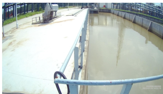
初期雨水收集池
