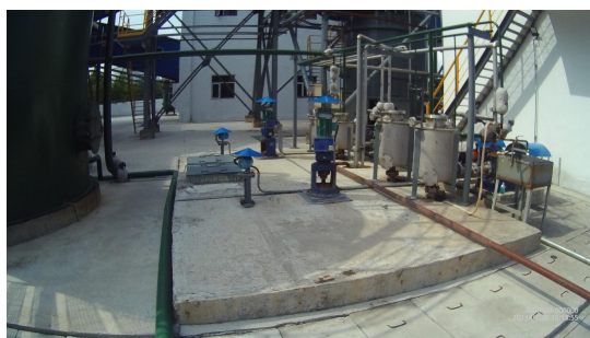
车间污水收集池
