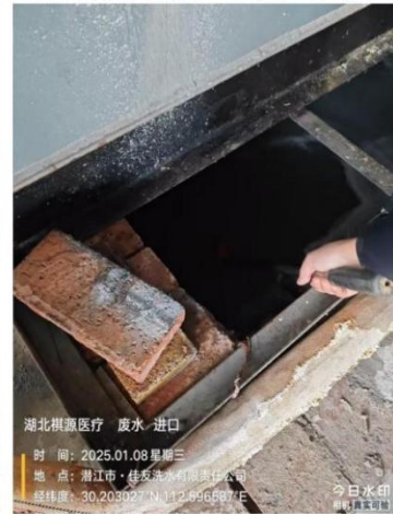
★1污水处理站进口
