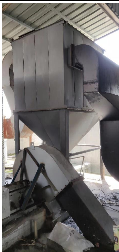
6t/h 锅炉布袋除尘器
