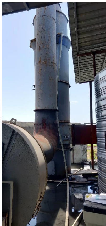
6t/h 锅炉水膜除尘器
